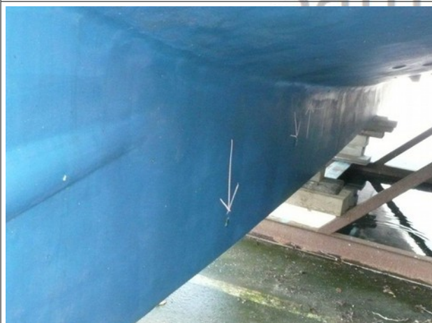
Osmose blazen aan stuurboordzijde
