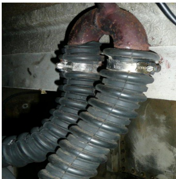
Tubanaslangen preventief vervangen
