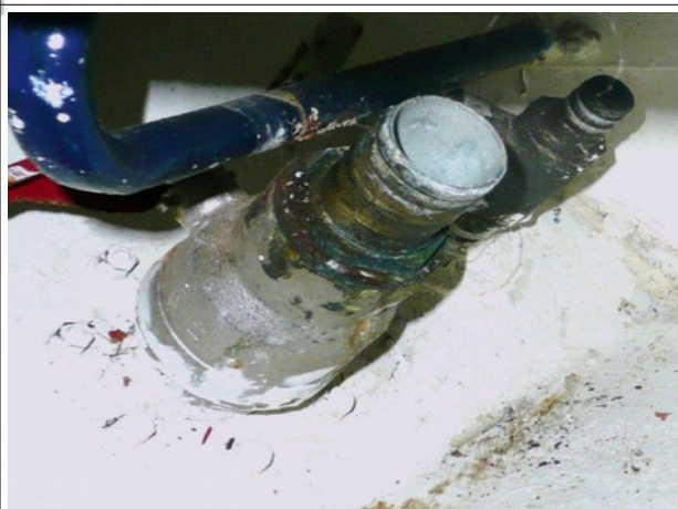
Ongebruikte afsluiters dubbel zekeren tegen ongewenste opening.
