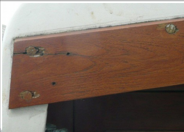
Slechte afwerking houten delen aan dek.
