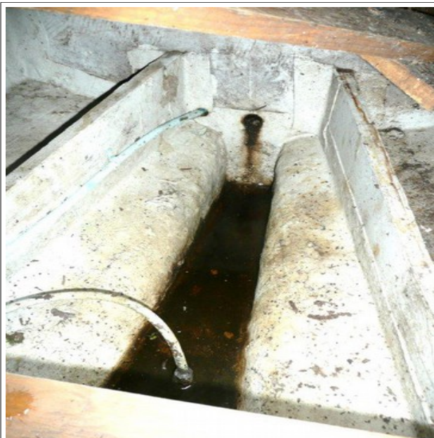
Water in de bilges verwijderen
