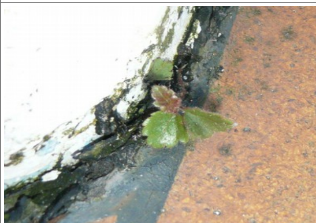
Flora in de naden van de dekbekleding
