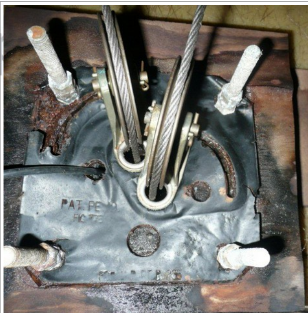
Onderdekse bevestiging van de stuurkolom nazien
